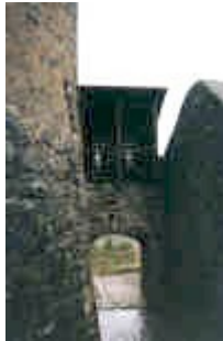
L'entrée vue de l'intérieur
